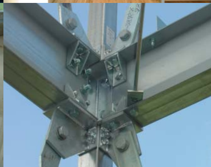
写真：名古屋モデルハウス施工事例
